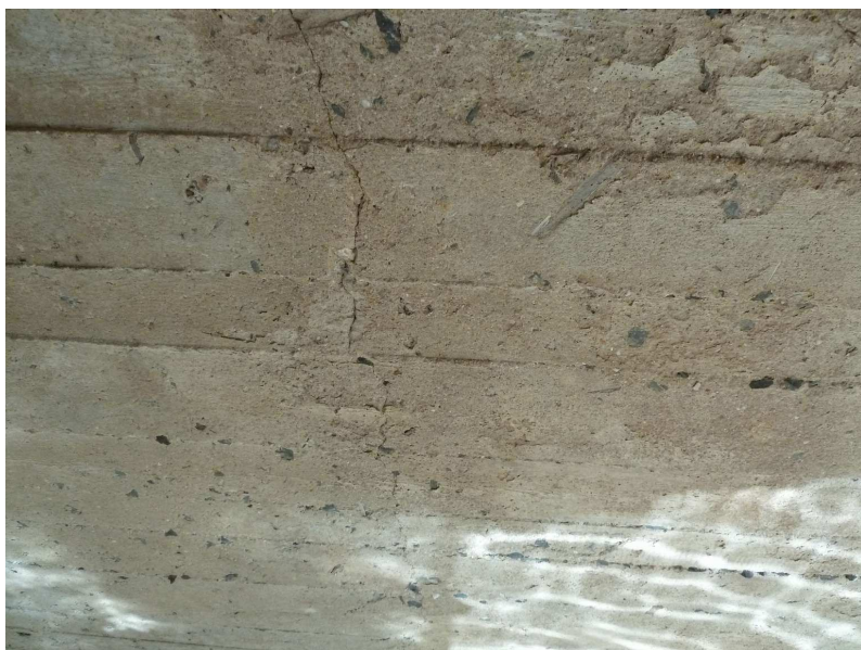
Podélná trhlina v podhledu nosné konstrukce
